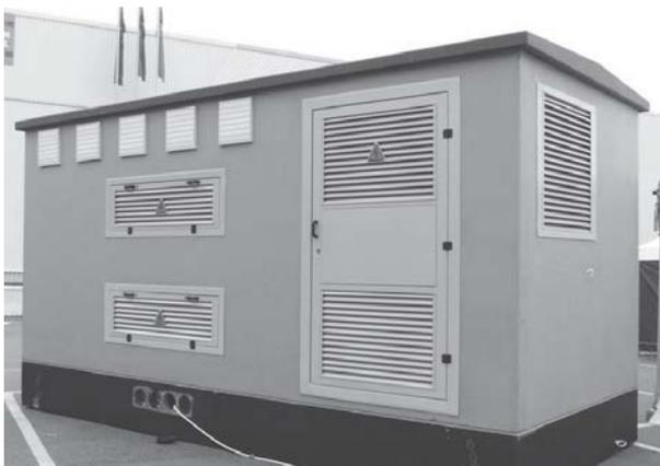
В системах електропостачання міських і промислових об'єктів, зон індивідуальної забудови, котеджних селищ і т.п. застосовуються **комплектні трансформаторні підстанції в бетонному корпусі (КТПБ)**.
