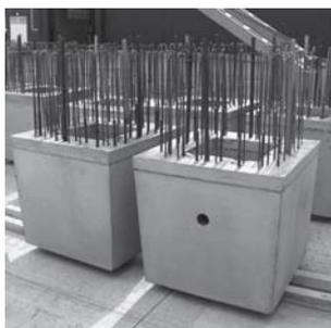
Фундаментні стакани з арматурними випусками для твердого з'єднання з ростверком.
