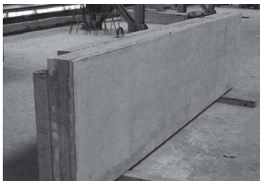
Збірна тришарова панель складається із двох залізобетонних шарів з теплоізоляційним шаром між ними. У якості теплоізоляції застосовуються негорючі утеплювачі.
