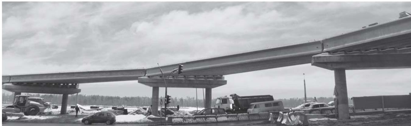
Попередньо напружені залізобетонні мостові балки виробництва «Обербетон» застосовані при будівництві естакади в рамках реконструкції розв'язки на Поштовій площі в Києві.
