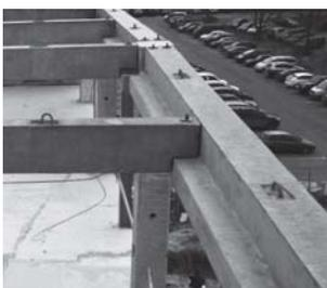
**Балки L-подібного перерізу**
