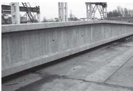
**Двоскатні балки двотаврового перерізу**
