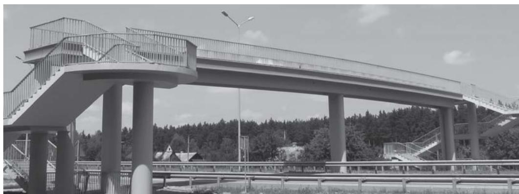
Залізобетонні мостові балки довжиною 16 м і 18 м виробництва «Обербетон» застосовані при будівництві пішохідного мосту на трасі Київ-Чоп у с. Березовка Житомирської обл.
