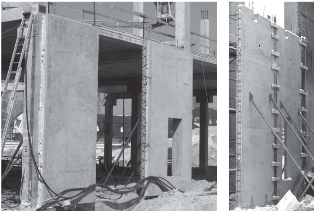
Будівництво ТРЦ «Прспект» з використанням тришарових і одношарових стінових елементів виробництва «Обербетон»
