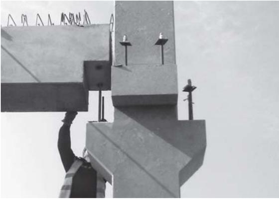
Вузол з'єднання колони з балкою, залежно від конструктивної схеми будинку, може бути шарнірним (мал. 7), шарнірним з жорстким диском перекриття (мал. 8).
